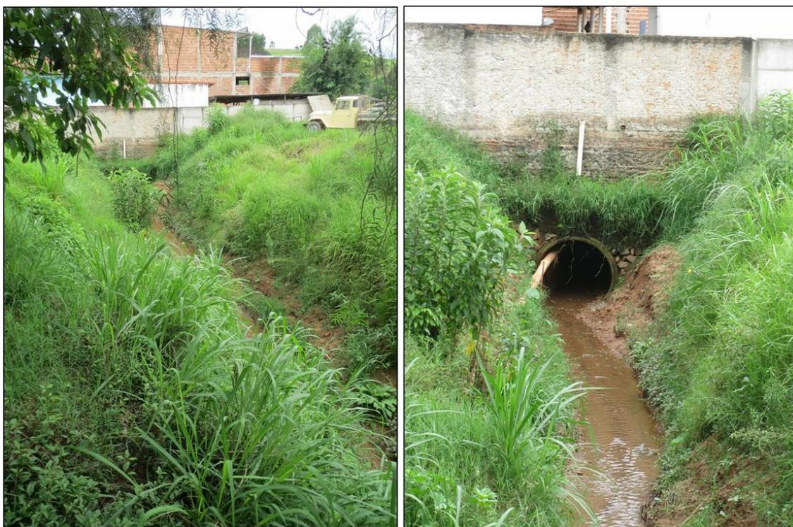
Figura 5.21. Lançamento de esgoto clandestino.
