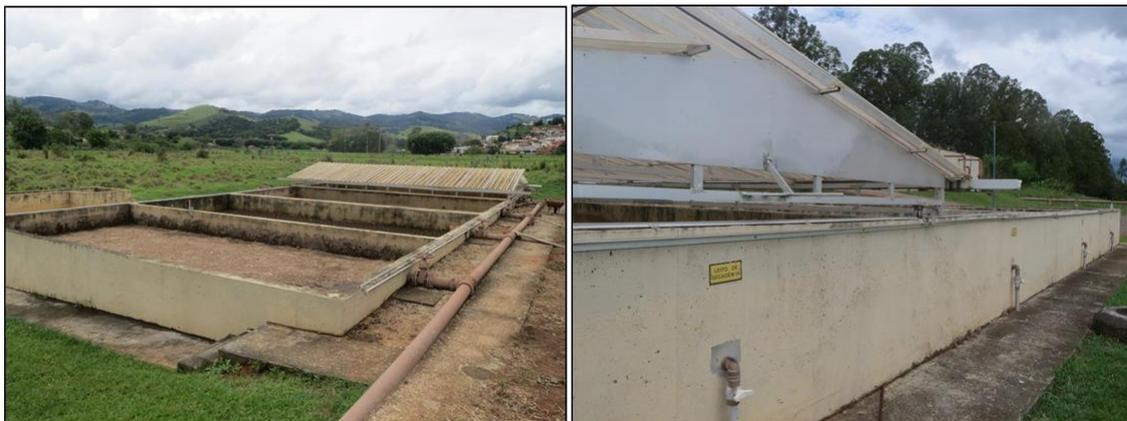
Figura 5.18. ETE Pedralva - Leito de secagem do lodo resultante do Reator anaeróbio.
